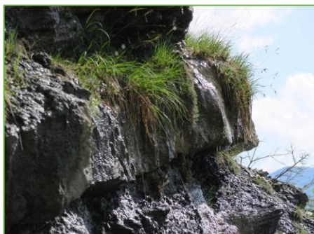
Suintement de Source pied de falaise
