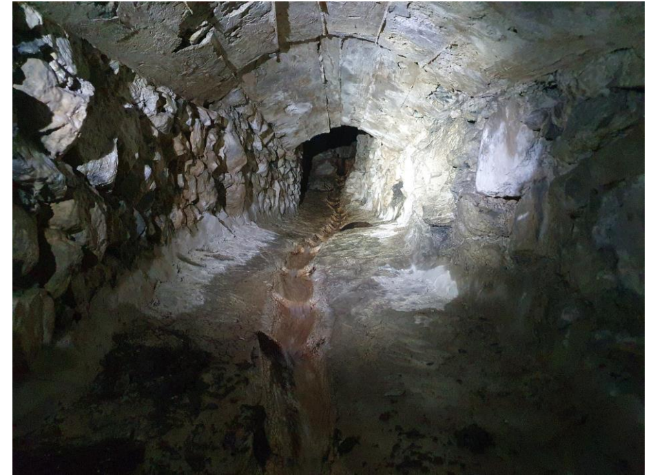
Captage et drain maçonné (Roya)
