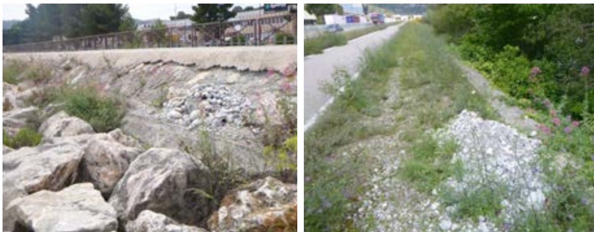
Gîtes en secteur contraint (à gauche) et en secteur végétalisé (à droite) ©V. RIVIERE
