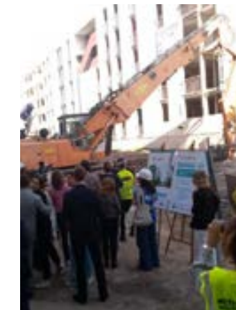
Démolition des bâtiments 6 et 8
