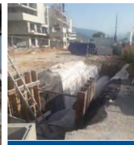
SAINT-LAURENT-DU-VAR : Dans le cadre du projet urbain partenarial des Pugets Nord, redimensionnement de la capacité du réseau des eaux pluviales du secteur
