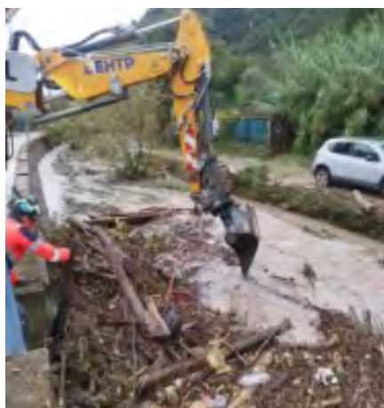
CARROS / LE BROCC : Curage du canal pied de coteaux suite aux intempéries du 23 octobre 2024 (afflux de sédiments et de bois morts en provenance du vallon du Riou).
