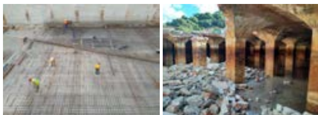
Démolition voûte et poteaux
