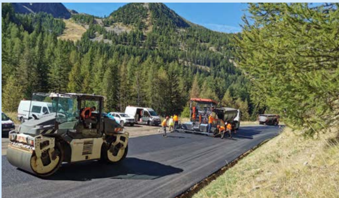
Expérimentation d'une nouvelle formulation de matériaux pour réfection de chaussée, dans le but de trouver une solution pérenne plus écologique.
