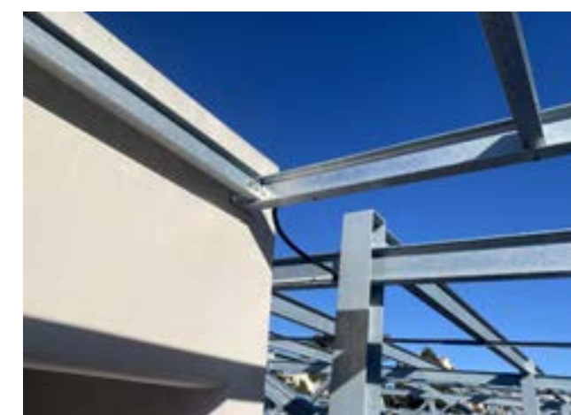
Travaux sur le parking Prévert à Carros.
