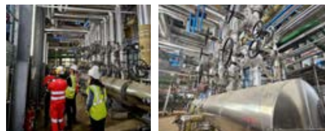
Montage des aérocondenseurs ; Nouveaux échangeurs pour la production d'eau chaude destinée aux abonnés du réseau de chaleur
