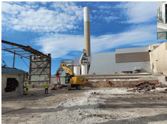
Démolition de bâtiments
