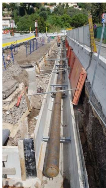
Dévoiement des réseaux
