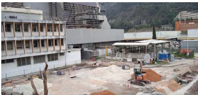
Dévoiement des réseaux
