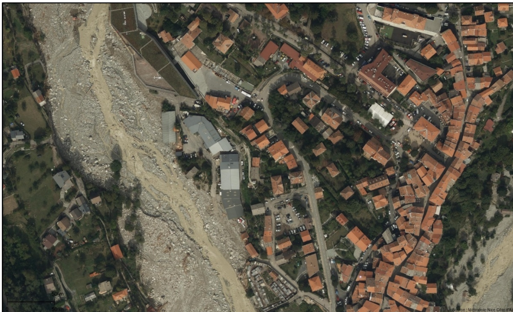
Zone d'Activité du Pra d'Agout après les intempéries de la Tempête Alex
