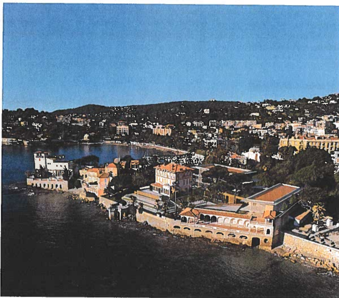
Projet futur avec insertion dans le site
