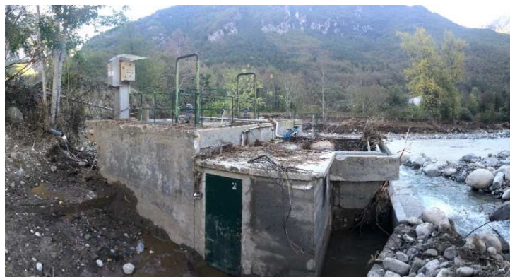
Ancienne station d'épuration du Suquet
