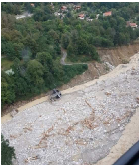
Ancienne station d'épuration du Touron
