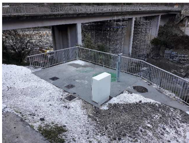
Création du poste de refoulement de Pont-Vieux
