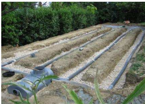
Travaux de réalisation d'un dispositif d'assainissement non collectif
