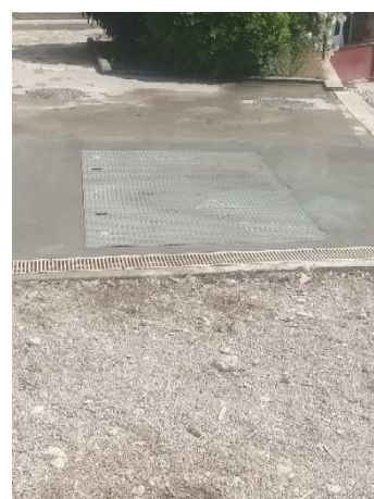
Remplacement de trappes de visite avec dispositif anti-chute
