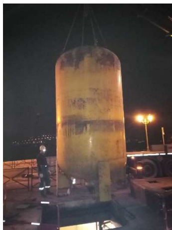
Remplacement de ballon anti-bélier
