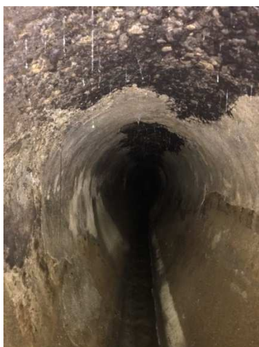
Ouvrage avant réhabilitation
