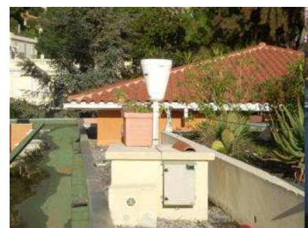
Pluviomètre situé à Beaulieu-sur-Mer (Ecole Lou Nistou)
