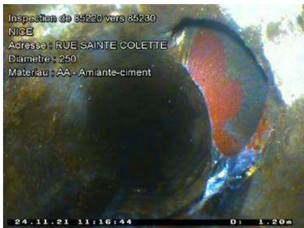
Ouvrage avant réhabilitation
