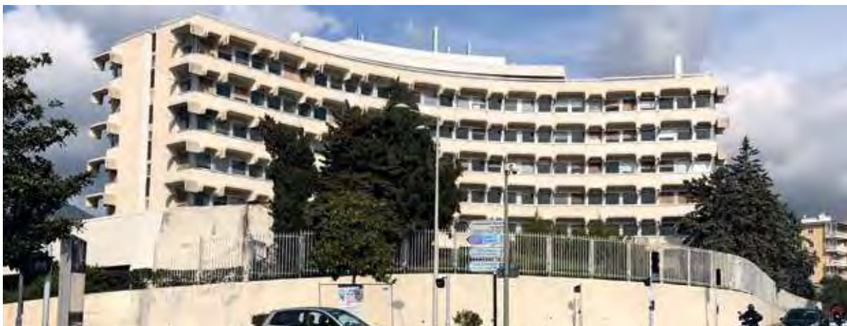
VUE DEPUIS L'AVENUE BRANCOLAR DU PROJET EXISTANT
