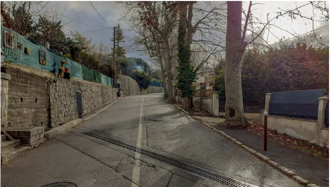
Emplacement 1 : chaussée Ouest – état actuel
