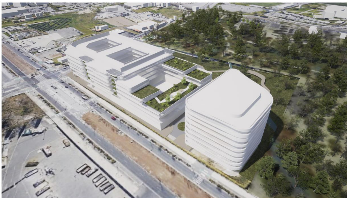
Insertion du projet – Vue aérienne Boulevard Simone Veil- en cours de travail architectural
