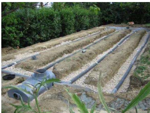
Travaux de réalisation d'un dispositif d'assainissement non collectif
