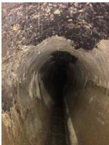
Ouvrage avant réhabilitation
