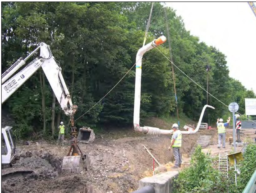
Illustration d'une baïonnette en cours de pose
