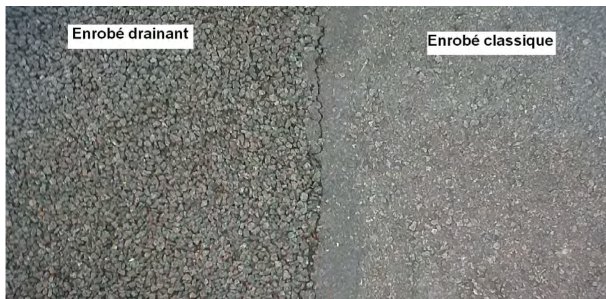
Enrobés drainant et classique (crédit FP)
