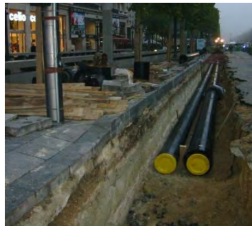
Réseau en pleine terre
