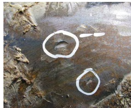
pioche / canalisation acier gaz HP
