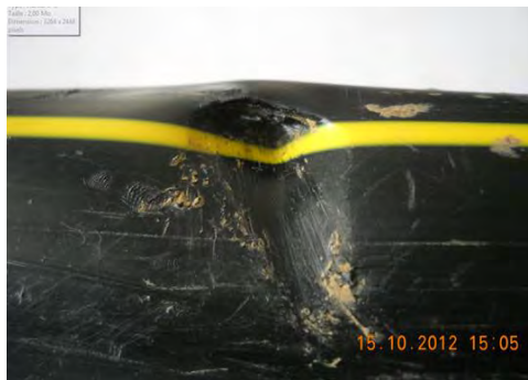
barre à mine / canalisation PEHD gaz MPB
