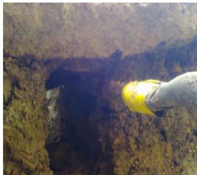
barre à mine / branchement plomb
