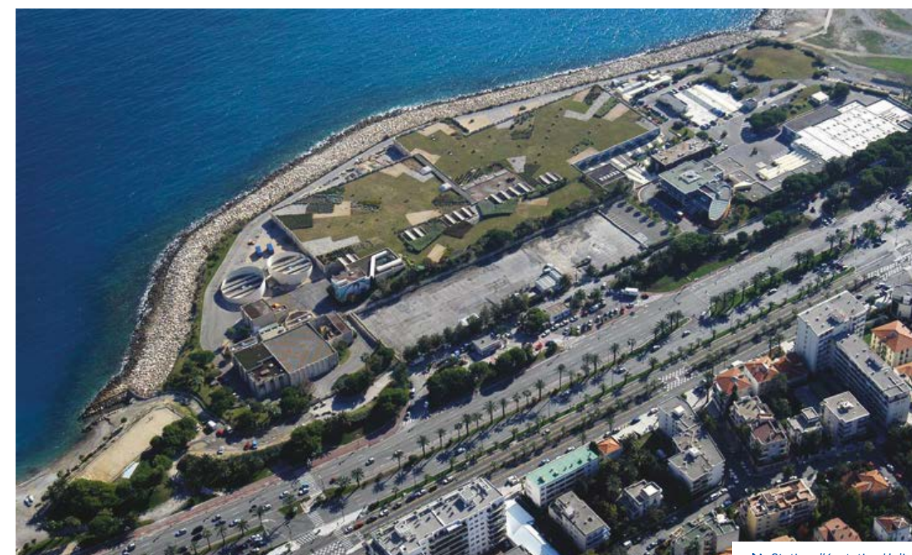
➤ Station d'épuration Haliotis
