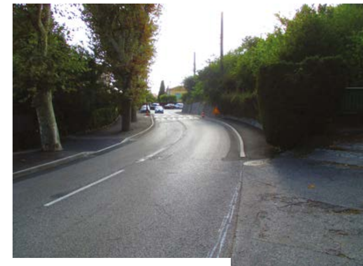
Renovation des trottoirs, avenue Matisse à Vence
