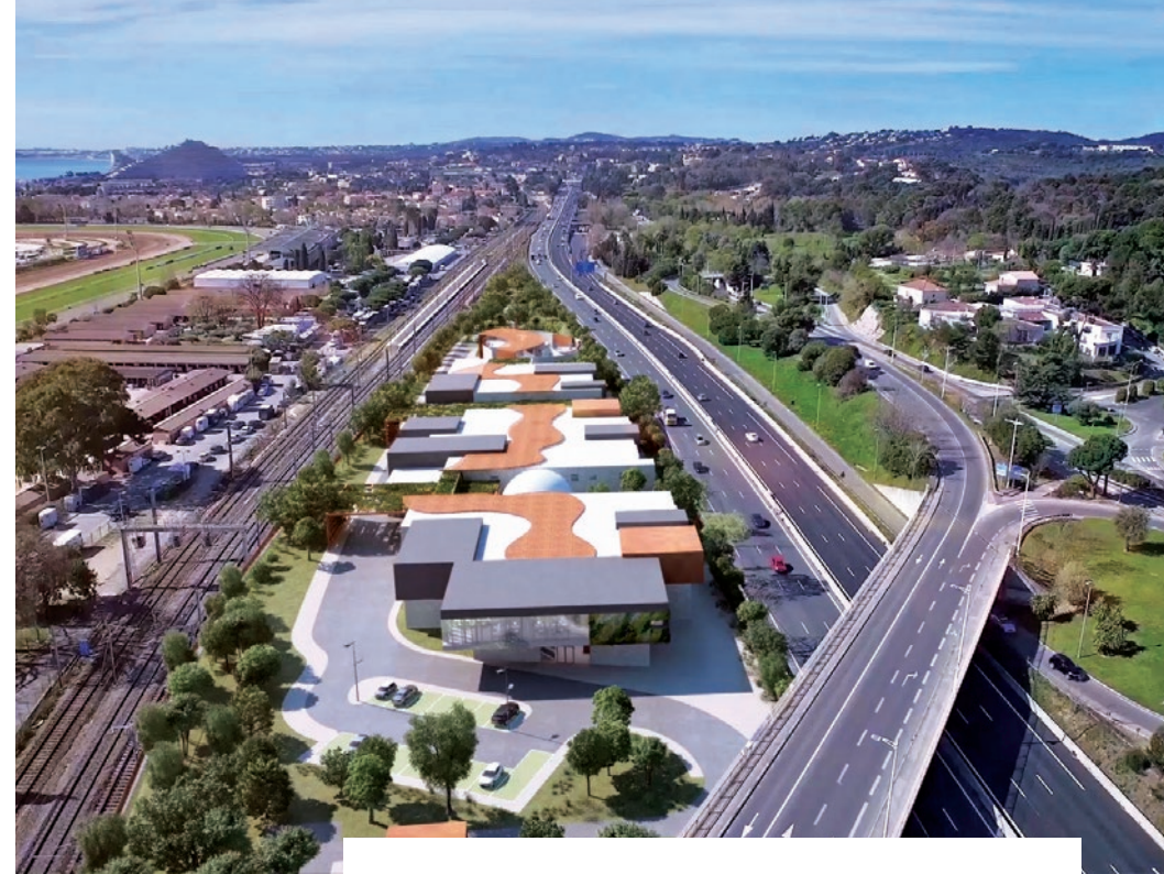
△ Station d'épuration Aérès Cagnes-sur-Mer
