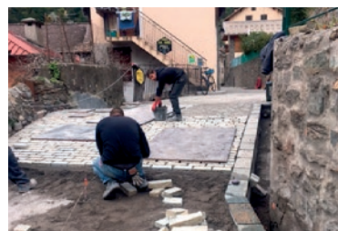
△ Isola, aménagement de la rue supérieure
