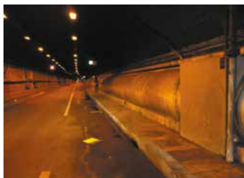
Mise aux normes des tunnels
