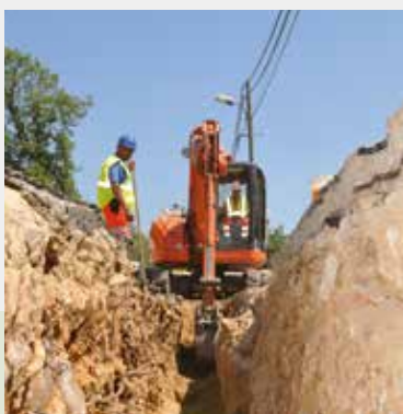
Extension des réseaux
