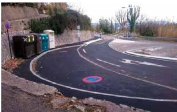
Vence , RM2210 / Baou des Noirs Aménagement de sécurité du carrefour
