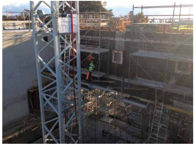
Photo des travaux de la nouvelle station d'épuration – Novembre 2018
