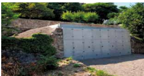
Travaux suite aux intempéries Saint-Jeannet , Chemin du Brusquet 75 000 € Ouvrage de soutènement en béton et enrochement
