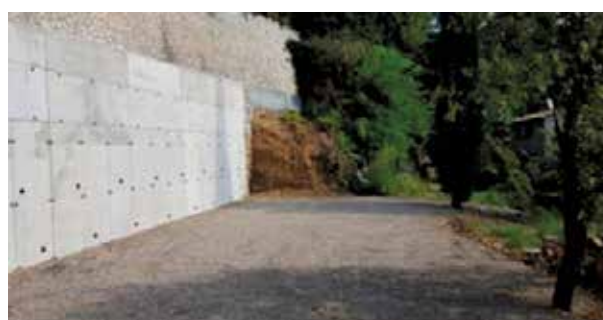
Carros RM1 au n°6984 - 100 000 € depuis l'Emigra Ouvrage de soutènement en béton
