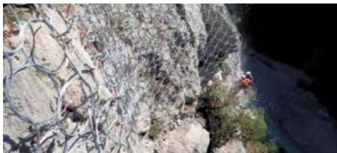
3) Mise en place d'un filet plaqué en tête de falaise
