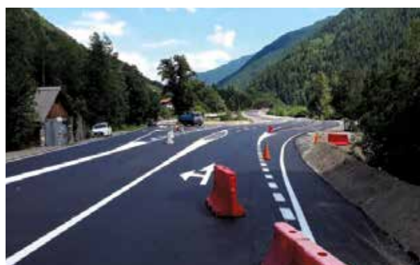
Saint-Étienne-de-Tinée : chantier test environnemental - recyclage des fraisats issus du rabotage de la chaussée - secteur de la Blache
