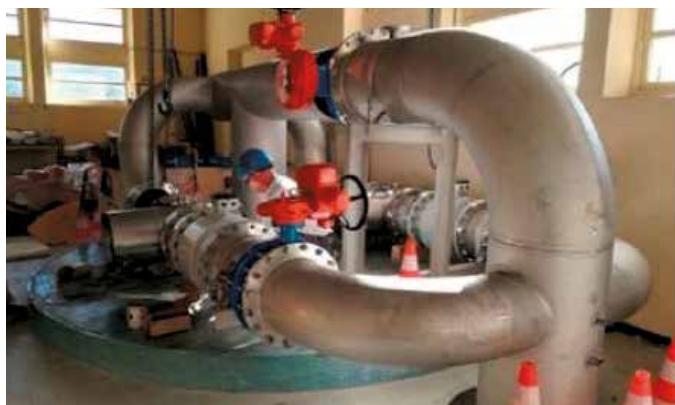
Travaux hydrauliques sur le traitement UV de l'usine de production d'eau potable de Bouyon. La Métropole participe financièrement aux investissements sous maîtrise d'ouvrage SIEVI ; l'usine alimentant en partie les habitants métropolitains de la rive droite du Var.
