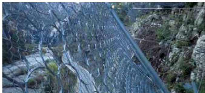
4) Remise en place d'un écran dynamique nouvelle génération
