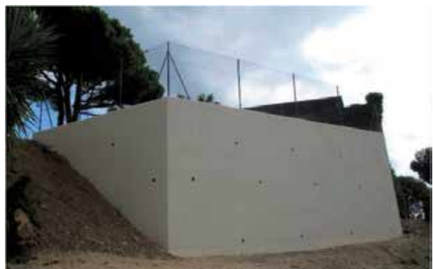
Cagnes-sur-Mer , chemin du Pain de Sucre : Aire de retournement dans le cadre du Plan de Prévention des Risques Incendies de Forêt
