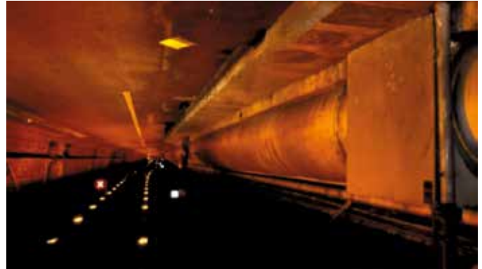
Mise aux normes des tunnels (Paillon)
