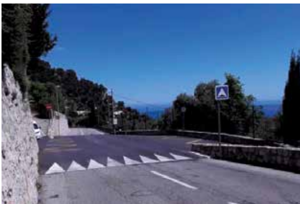
Villefranche-sur-Mer : mise en place d'un dispositif ralentisseur avec création d'écluse et plateau traversant
