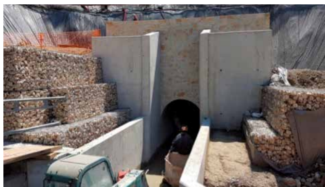
Fin des travaux de réhabilitation du canal de la Vésubie, au niveau du tunnel de la Roquette
