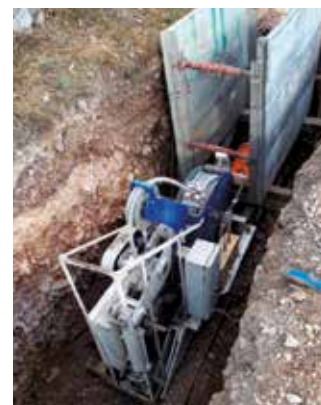
Poursuite du tubage du canal d'adduction du Riou à Vence sur plus de 1,3 km (tranche 2018).
