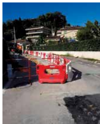
Renouvellement et renforcement du réseau d'eau sur 365 m, chemin des Noisetiers à Cagnes-sur-Mer.
