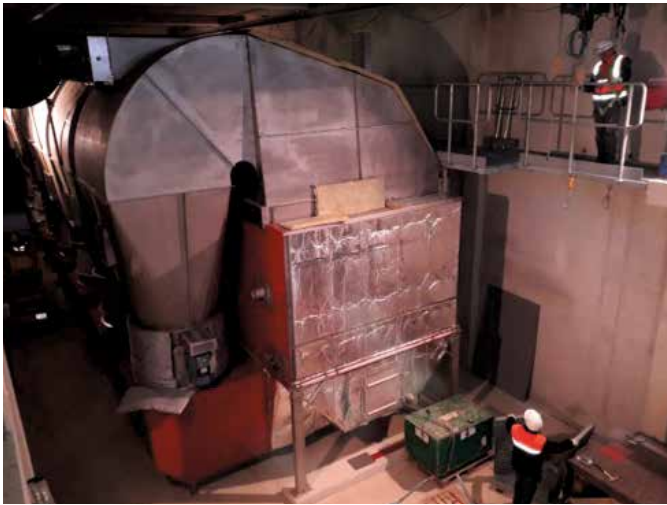
Photo des travaux de la station d'épuration – Sécheur - Novembre 2018
