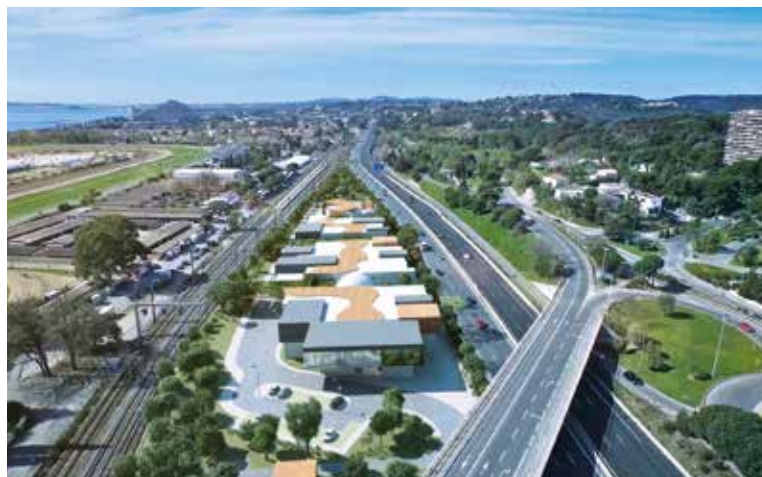
▼ Cagnes-sur-Mer / Nouvelle station d'épuration
